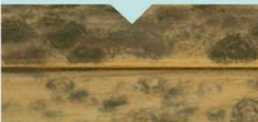
Des moisissures provoquées par des champignons, résultant de la chaleur, de l'humidité ou le manque d'aération, peuvent apparaître à la surface du bois. Un brossage permet de les éliminer.
